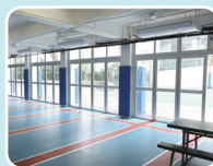
2020年 操場加裝空調設備 重鋪安全地墊
